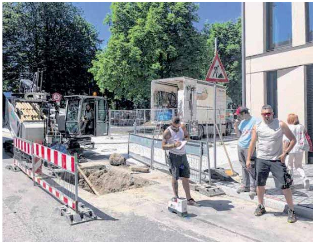
Bei den Arbeiten vor der Residenz war eigens ein Sachverständiger eingebunden, der das empfindliche Wurzelwerk der ehrwürdigen Bäume schützte (links). Das rechte Bild zeigt im Hintergrund die Spezialmaschine, mit der die Spülbohrung von der Sparkasse Richtung Hofgarten vorangetrieben wurde.
