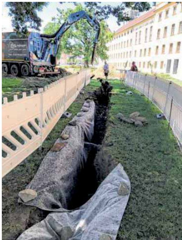
Bei den Arbeiten vor der Residenz war eigens ein Sachverständiger eingebunden, der das empfindliche Wurzelwerk der ehrwürdigen Bäume schützte (links). Das rechte Bild zeigt im Hintergrund die Spezialmaschine, mit der die Spülbohrung von der Sparkasse Richtung Hofgarten vorangetrieben wurde.
